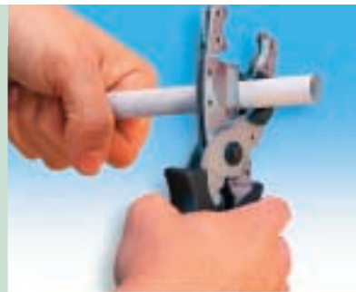
Рис. 1. Отрежьте металлопластиковую трубу перпендикулярно ее оси с помощью трубореза или специальными ножницами
