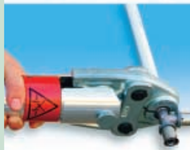
Рис. 1–4. Монтаж труб с применением пресс-фитингов PRESSFAR
